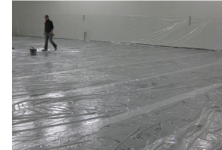
Die Betonschicht wird anschließend mit einer Folie bedeckt und so vor Austrocknung und zu früher Schwindung geschützt.
